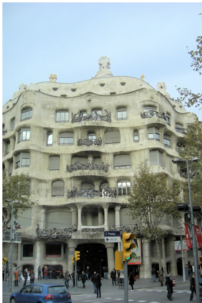
Casa Mila, 1910 fertiggestellt, wegen seiner unregelmäßigen Fassade spöttisch als "Der Steinbruch" bezeichnet, gehört inzwischen zum UNESCO- Weltkulturerbe
