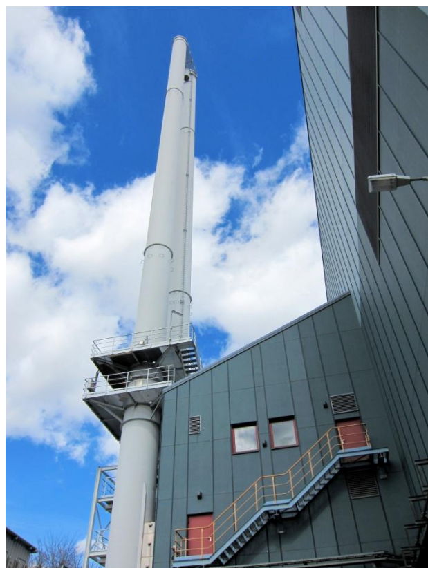
Das Analysehaus mit dem Doppelkamin. Hier werden die Abgaskonzentrationen laufend analysiert
