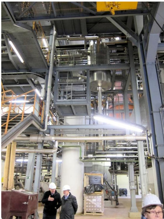
Teil der Abgasreinigung
